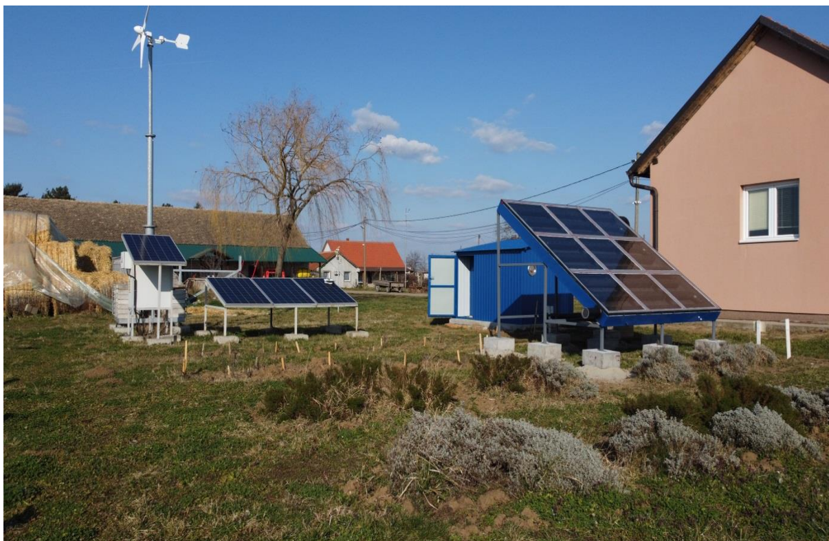
Слика 2. Соларна сушара и помоћно хибридно постројење за производњу енергије на бази сунца и ветра.
